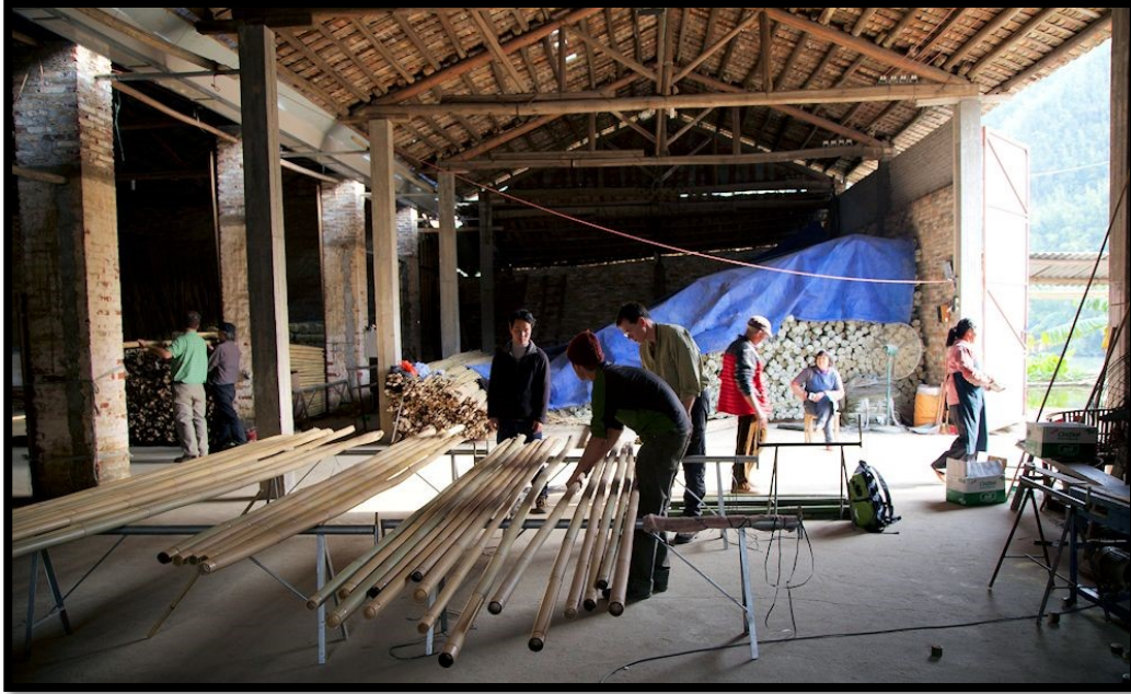
Fig. 12 Warehouse for Tonkin (© Chad Okrusch).
